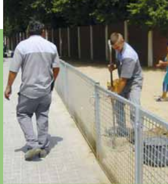
▲ Treballs de senyalització del pipi-can del carrer de les Estrelles.
