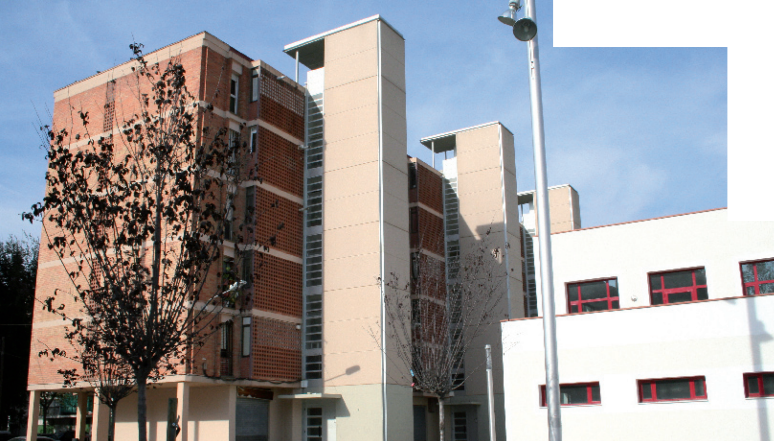
Instal·lació d'ascensors adossats a la Mina Vella que aprofiten l'espai entre blocs. 300 famílies es beneficien d'aquesta millora.
