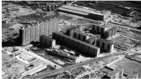
La Mina Vella, es correspon a la primera fase d'edificació, són blocs més petits i de cinc plantes.
