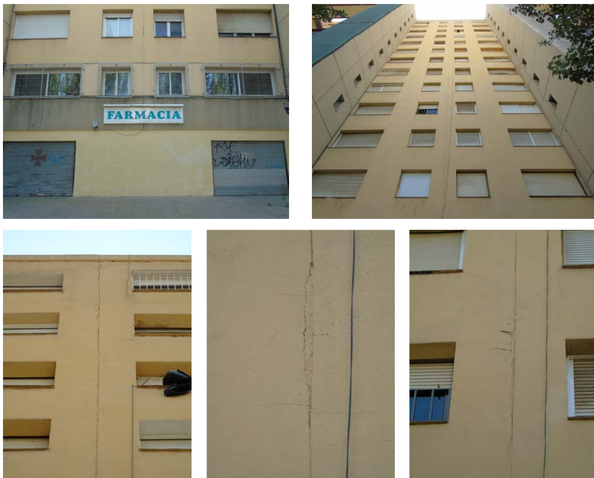
Figura 13. Juntes estructurals verticals de l'edifici
