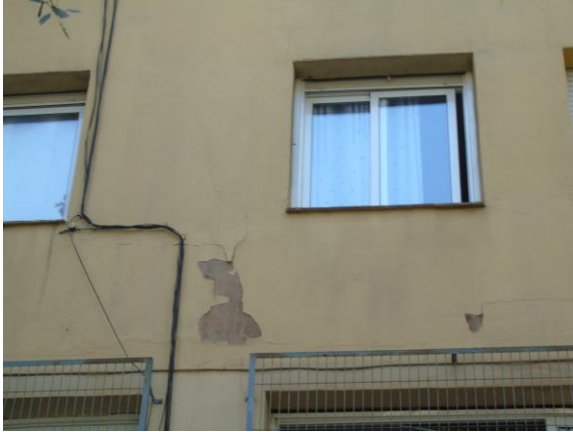
Figura 11. Fissures a la façana nord-est
