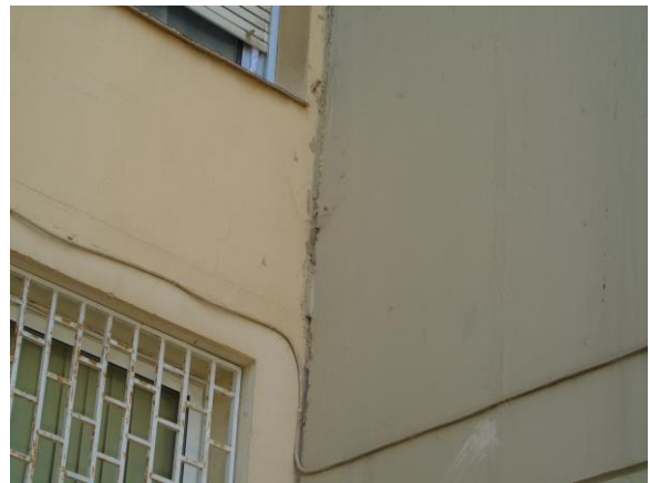
Figura 12. Falta de segellat a les juntes
