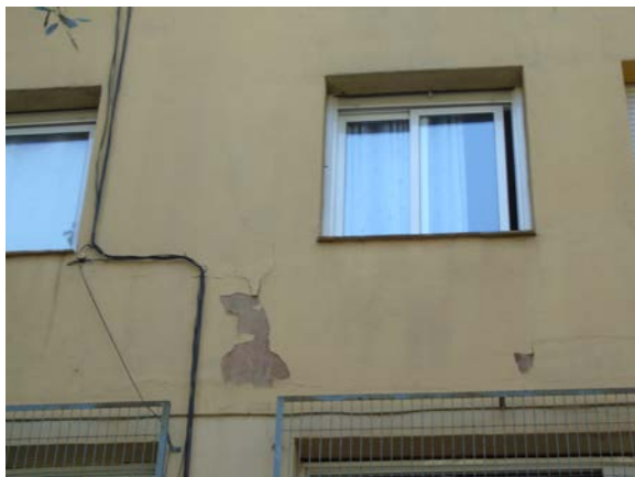
Figura 11. Fissures a la façana nord-est
