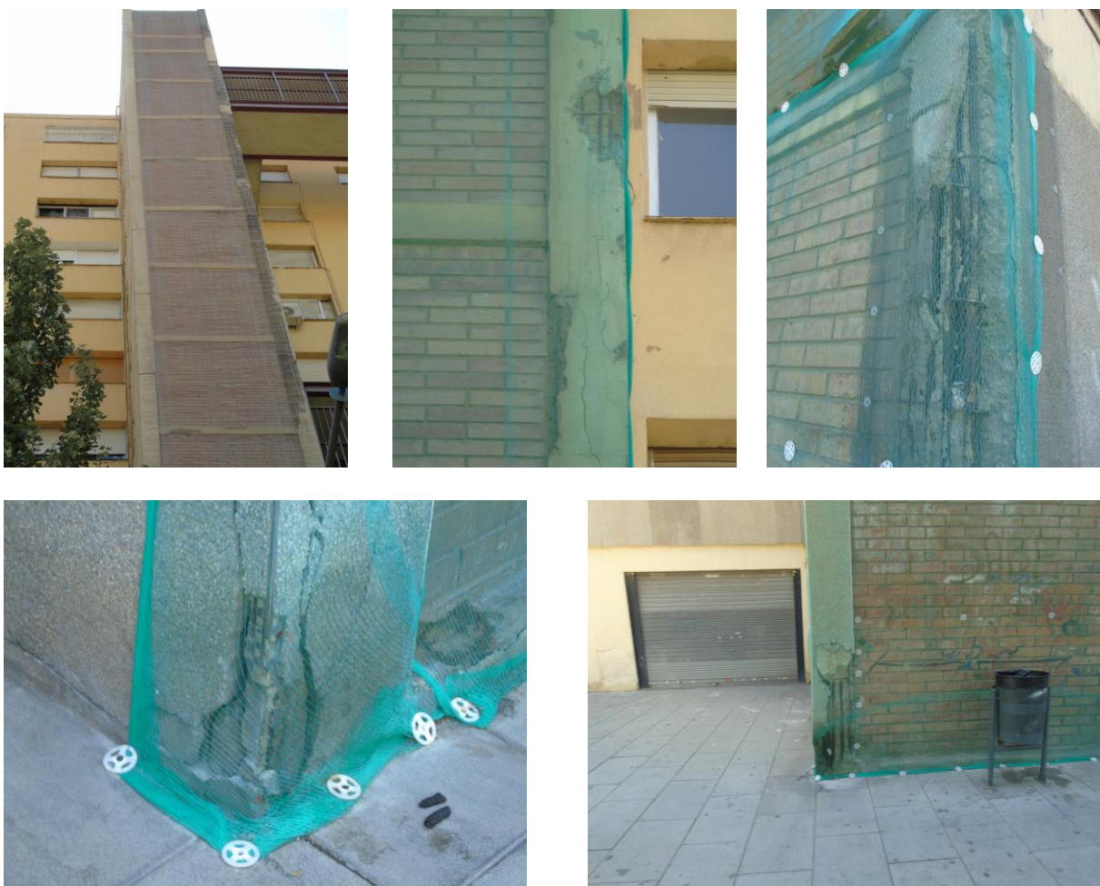
Figura 6. Despreniments a les caixes d'escaleres
