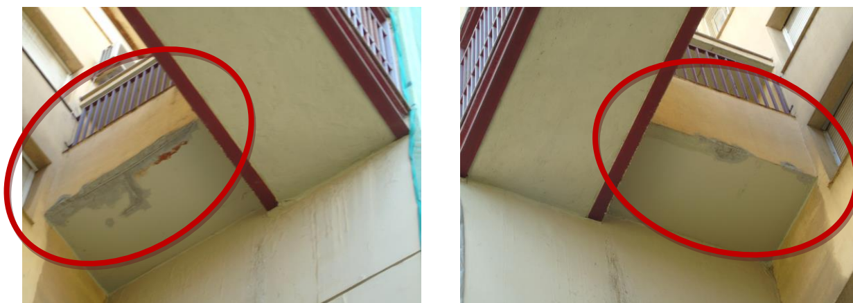
Figura 8. Formigó armat passivat
