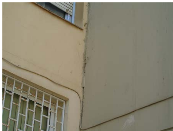
Figura 12. Falta de segellat a les juntes
