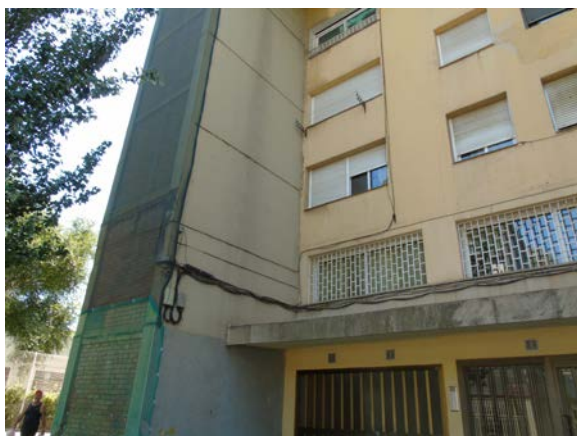
Figura 12. Falta de segellat a les juntes
