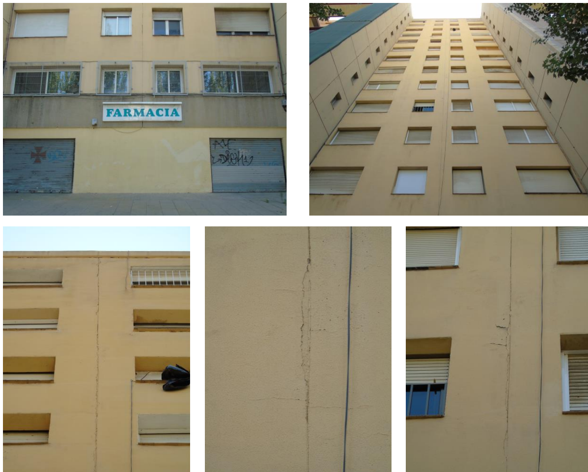
Figura 13. Juntes estructurals verticals de l'edifici
