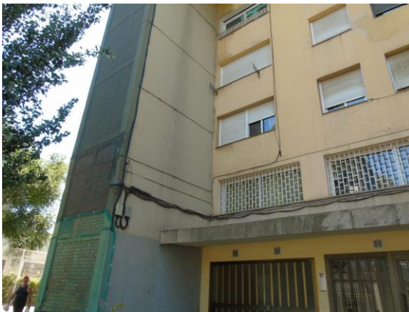
Figura 12. Falta de segellat a les juntes
