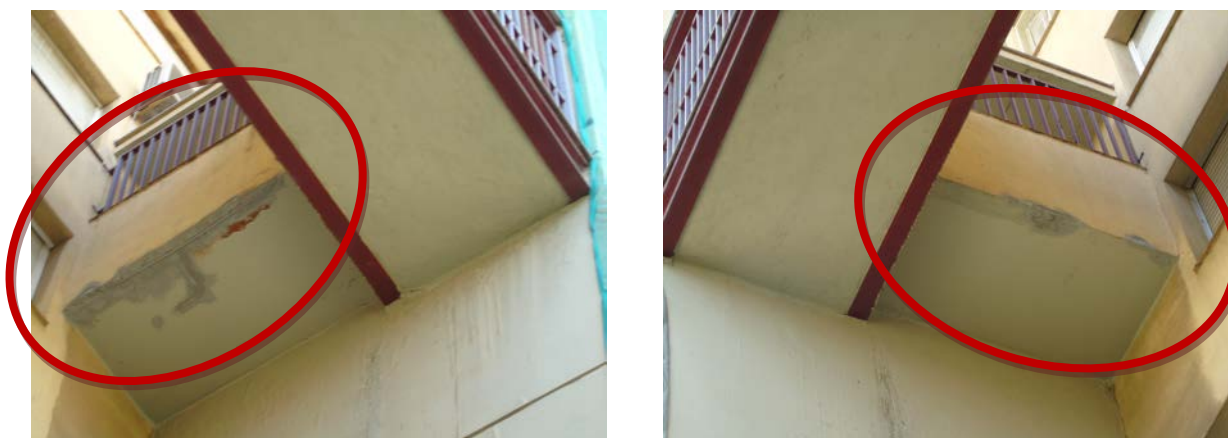
Figura 8. Formigó armat passivat
