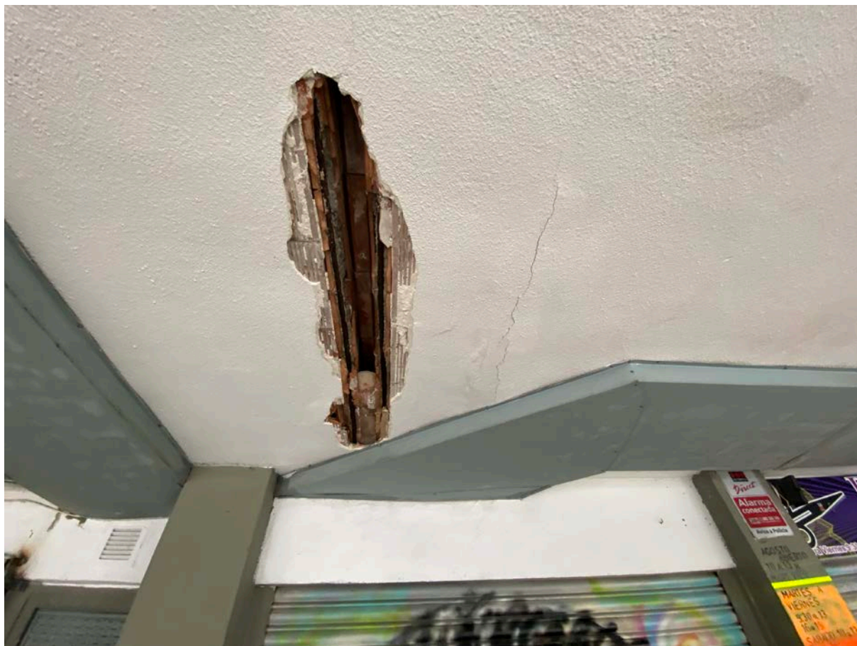
Figura 6. Fotografia del sostre on es veu una biga malmesa i el tipus de reparació a executar
